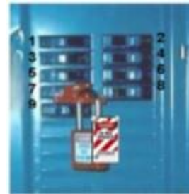
Figure A-4, LOTO pour interrupteur
